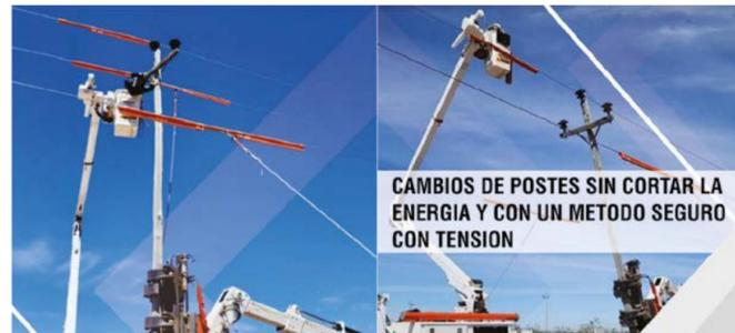
**CAMBIOS DE POSTES SIN CORTAR LA ENERGIA Y CON UN METODO SEGURO CON TENSION**
